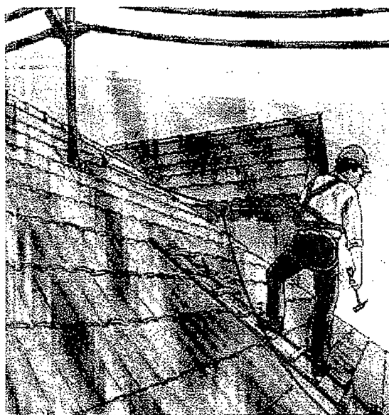
6. ábra Munkavégzés tetősíkon rögzített tetőlétráról
