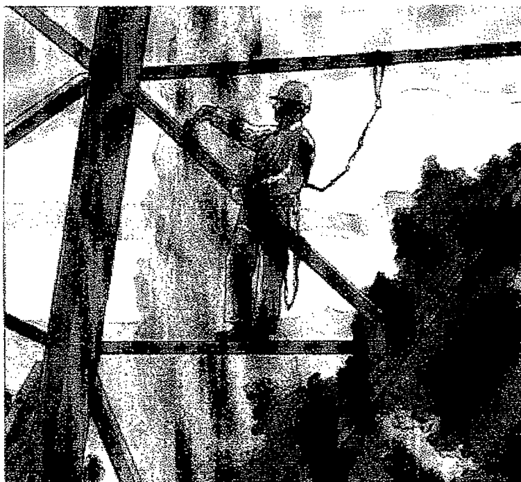
5. ábra Munkavégzés rácsos szerkezeten
